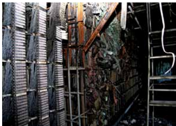
Рис.17. Кросс после пожара. Фотография предоставлена блоггером dkphoto http://dkphoto.livejournal.com/
